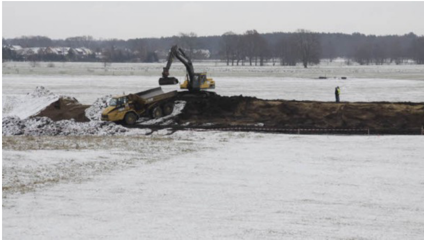
Baulos 1: Holzungen und Bodenabtrag im Bereich des künftigen Deiches. Fotos: Lars Reinhold
