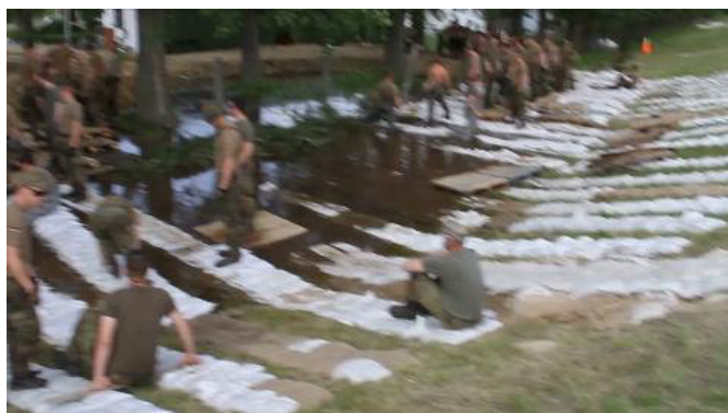
Sicherung des Rehwisch-Deiches (0:09)
